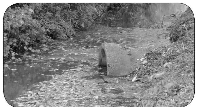
■ Duiker onder het fietspad door.
